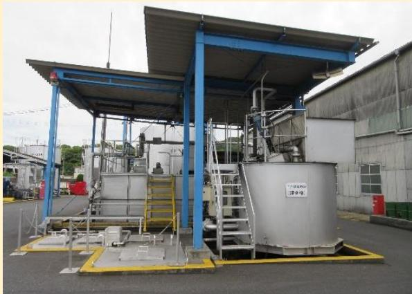
混合調整施設：混合槽（リサイクル燃料）
